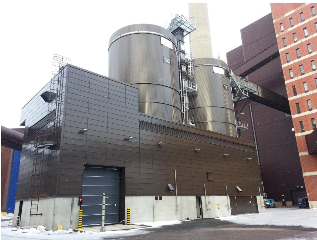
Kuva 4. Salmisaaren pellettsiilot - Kuva: Helen Oy
