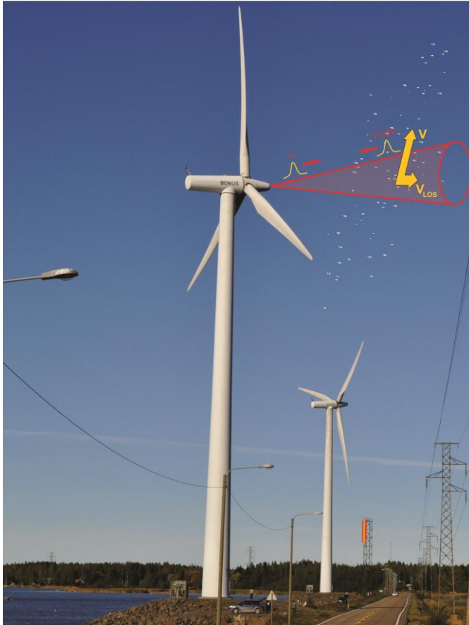
Kuva 2.3 Tuulivoimalan konehuoneeseen asennettu LIDAR on osa ennakkoivaa turbiinohjausjärjestelmää.
