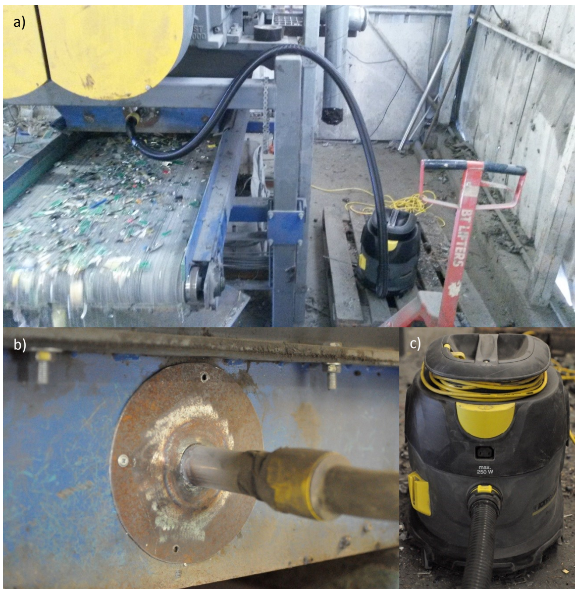
Kuva 30 a) Asennettu teollisuusimuri pölyjen talteenottoa varten b) imurin liitoskohta ja c) lähikuva käytetystä Kärcher-teollisuusimurista
