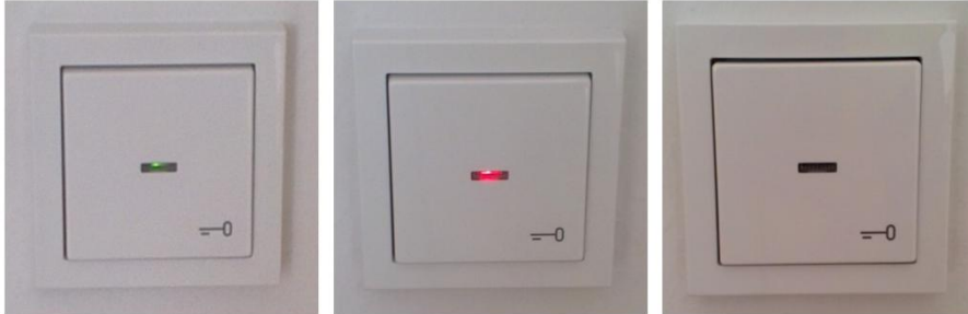
Kuva 8.6. Huoneistokohtaisen kytkimen kolme eri asentoa ilmaistaan kytkimessä olevan ledin avulla.
