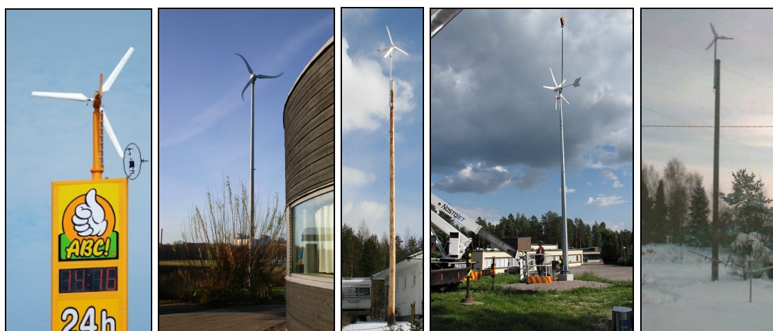
Kuva 39 Tuulivoimaloita joiden mitattu vuosituotto on 2000 kWh, 1000 kWh, 75 kWh, 38 kWh ja ~ 0 kWh. Tehot 0,4 – 10 kW. Tarkemmat tiedot liitteessä C. [57] [58] [59]
