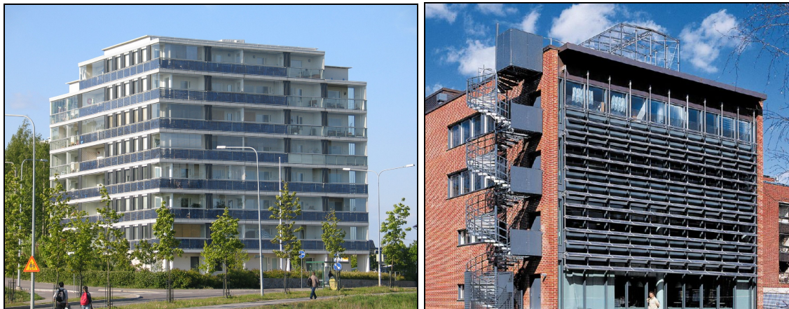
Kuva 37 Vasemmalla kerrostaloon integroidut aurinkopaneelit Helsingissä, vuosituotanto noin 12 000 kWh. Oikealla Espoon Teknillisen korkeakoulun paneelit, tuotanto 4000 kWh. [56]
